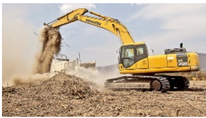
Tras seis meses de retraso inició la construcción del Centro Logístico Jalisco, con la limpieza de vialidades y el movimiento de tierras.
